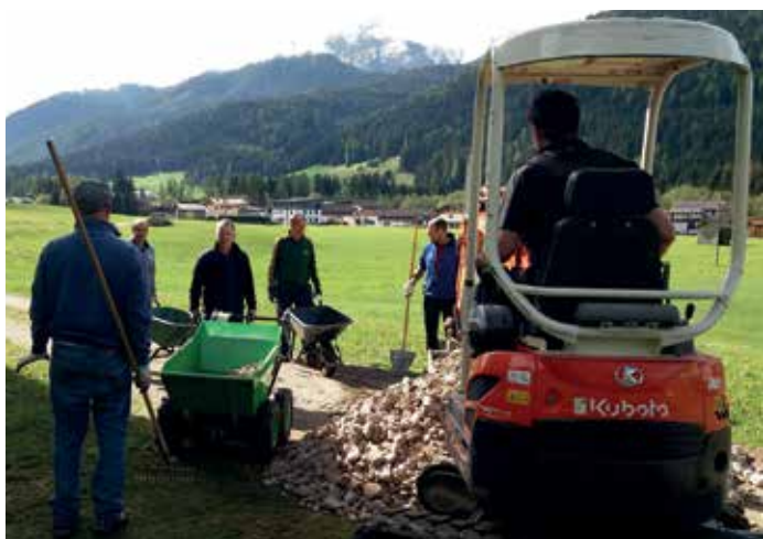
Baggerarbeiten, durchgeführt von Andreas Sinner
