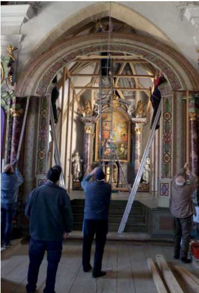
Die Grabaufsteller bei der Arbeit
